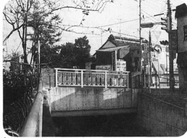
↑現在の吹上橋
